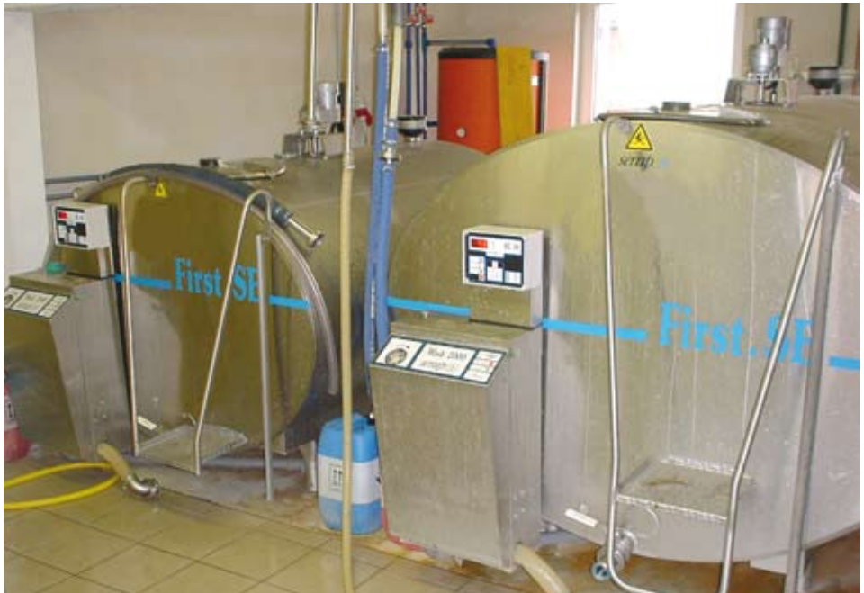
Milchlagerraum getrennt vom Stallbereich. Foto: LMTZ
